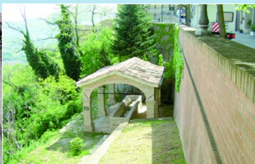
RISTRUTTURAZIONE DEL LAVATOIO
